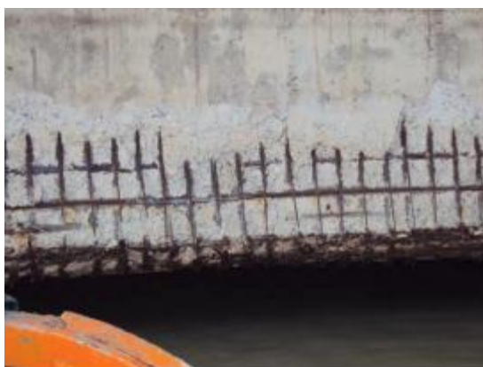
Foto 46- Concreto disgregado com armadura exposta e oxidada na VPT entre estacas E6 e E43
