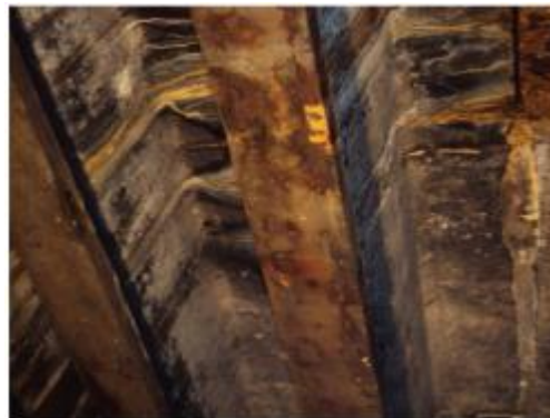
Foto 39- Mesa inferior da VSIb103 presença de concreto disgregado com armadura exposta e oxidada.
