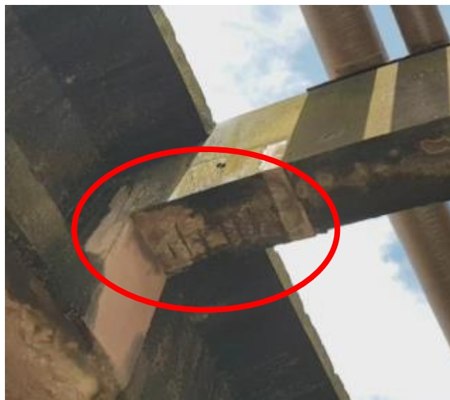
Figura 23 – Concreto Disgregado com AEO Superficial na Viga VT3 da Ponte de Acesso
