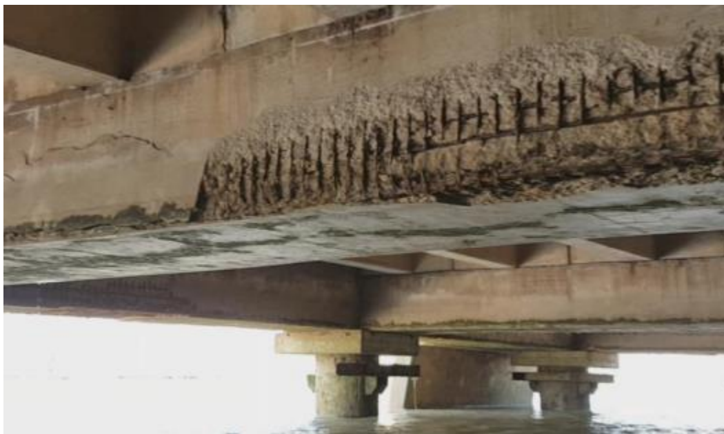
Figura 28 – Concreto Disgregado com AEO Profundo na Viga VPT03
