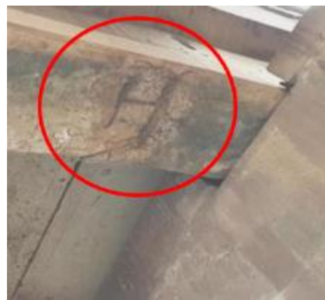
Foto 95- Concreto Disgregado com armadura exposta e oxidada (espessura <4cm) na VL3
