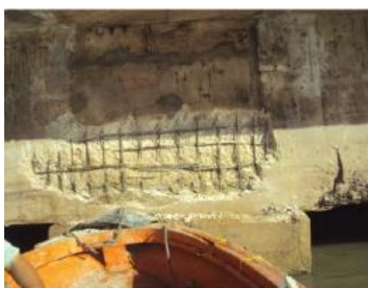
Foto 86- Corrosão nas armaduras com seccionamento de estribos.
