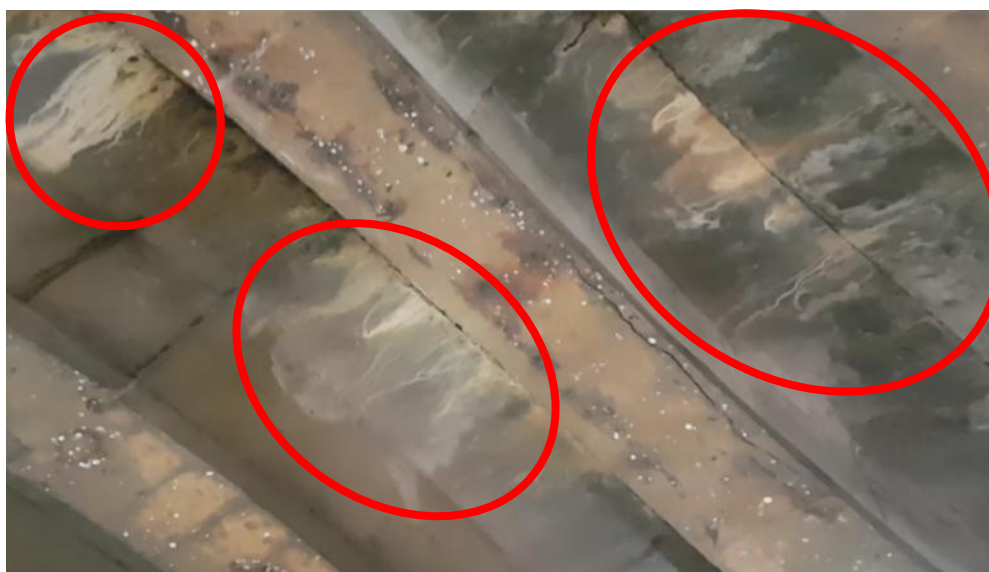
Figura 21 – Manchas de Eflorescência na viga VSEc20
