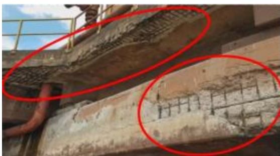
Foto 91- Concreto disgregado profundo (prof. > 4cm) no bloco BL2.
