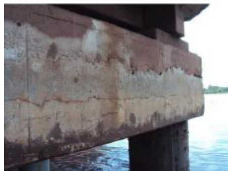
Foto 6 - BL2 – Concreto disgregado.
