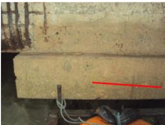
Foto 35- Concreto Disgregado e fissura no capitel da estaca E1.
