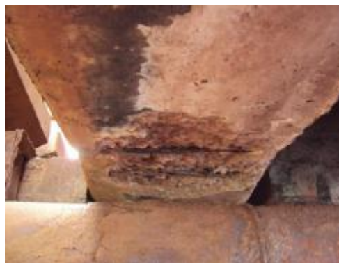
Foto 24– Concreto Disgregado com perda de seção nas armaduras da VL3.
