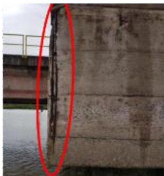
Foto 107 –Concreto Disgregado profundo com armadura exposta e oxidada.
