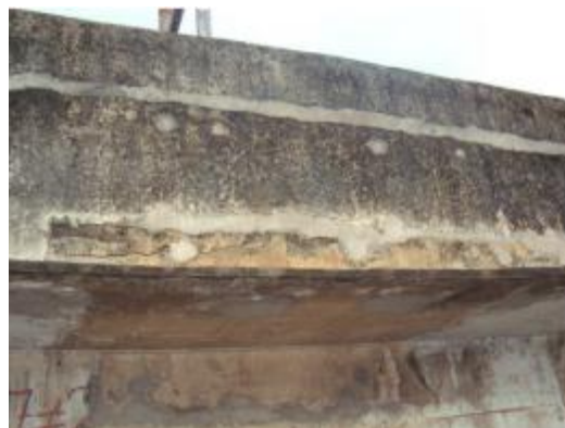
Foto 50- Manchas de eflorescência na aba da viga VPT entre estacas E6 e E43.
