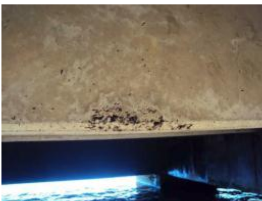
Foto 67- Concreto segregado na alma da VT4 entre E4 e E5 / E41 e E42.
