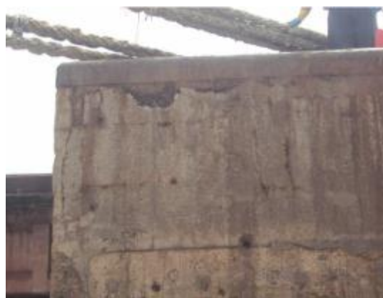
Foto 72- Concreto disgregado com armadura exposta e oxidada no Delfim D9.
