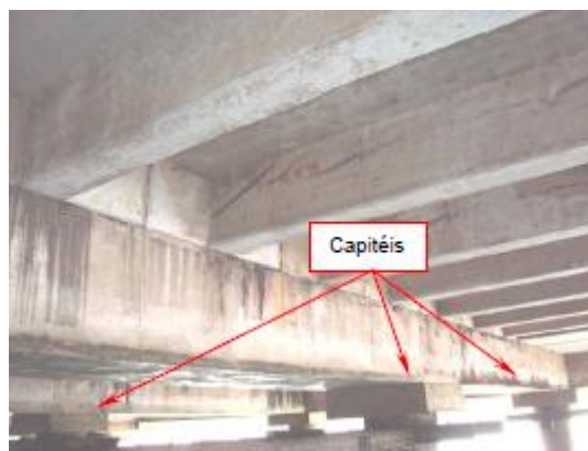
Figura 14 – Vista dos Capitéis da Plataforma de Operações
