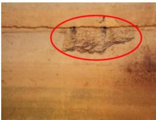
Foto 63- Concreto disgregado na VT3 entre E2 e E3 / E40 e E39.
