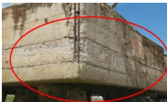
Foto 110- Exposição de agregado graúdo
