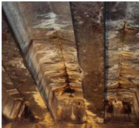
Foto 33- Face inferior da mesa superior com manchas de eflorescência e oxidação na VSE.
