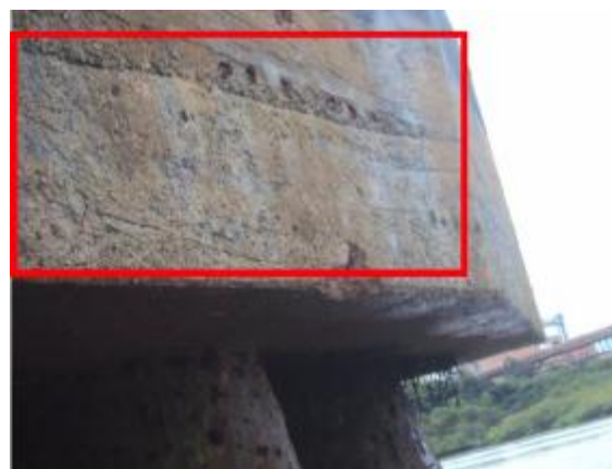
Foto 76- Exposição de agregado graúdo no Dolfim D7.
