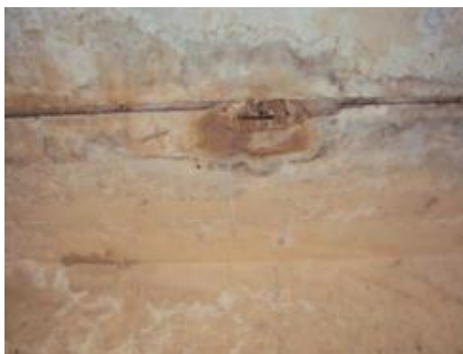
Foto 66- Concreto disgregado com armadura, exposta e oxidada na VT3 entre E7 e E4 / E41 e E37.
