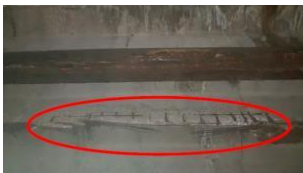
Foto 51-Concreto disgregado profundo armadura exposta e oxidada
