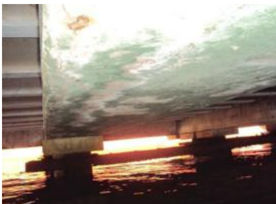
Foto 41- Manchas de maneira generalizada na face lateral da VPT entre E3-E40.
