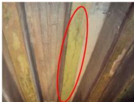
Foto 43- Mesa inferior VS1a com concreto disgregado e fissuras.
