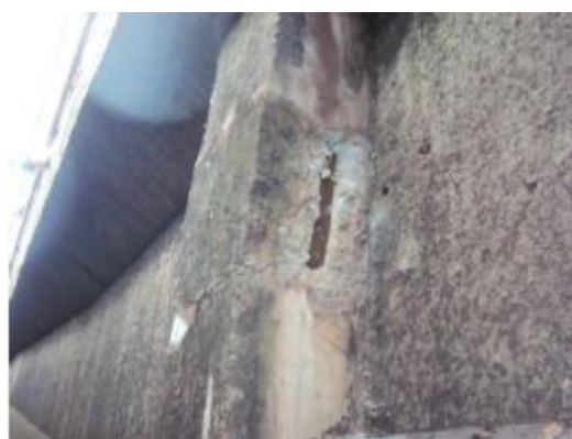
Foto 28- Concreto Disgregado com armadura exposta na VT5.
