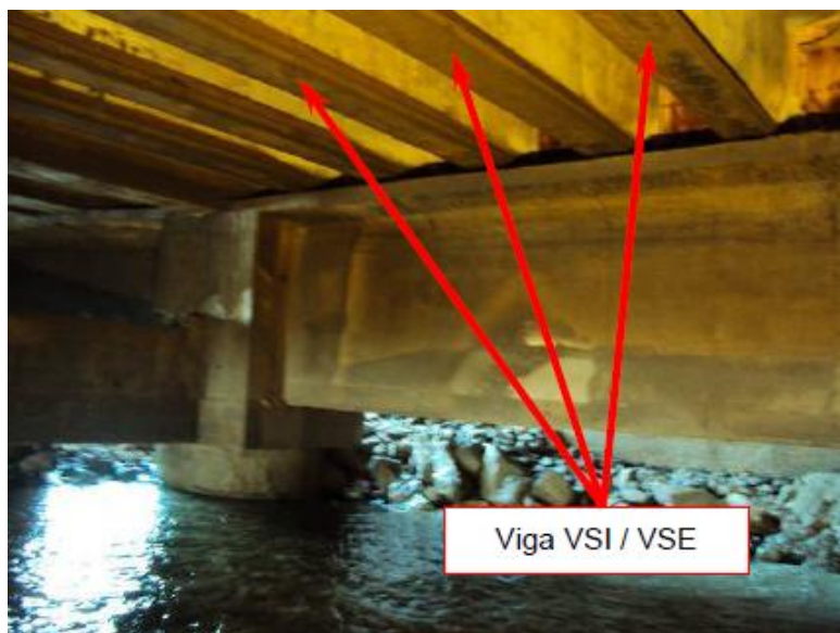
Figura 11 – Vista das Vigas VSIa, VSIb e VSE
