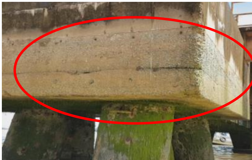
Figura 40 – Concreto Lixiviado no Dolfim D5
