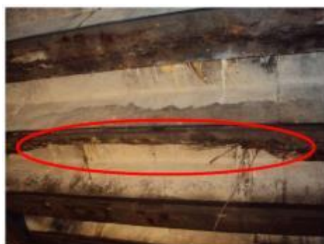
Foto 45- Face inferior da VSEb93 com cordoalhas rompidas.
