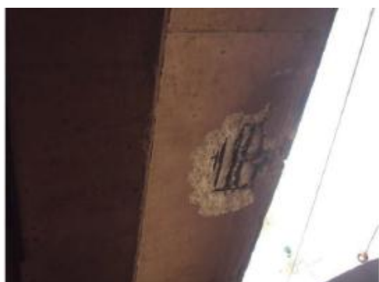
Foto 31- Concreto Disgregado com armadura exposta na face inferior da laje da plataforma de bombas.
