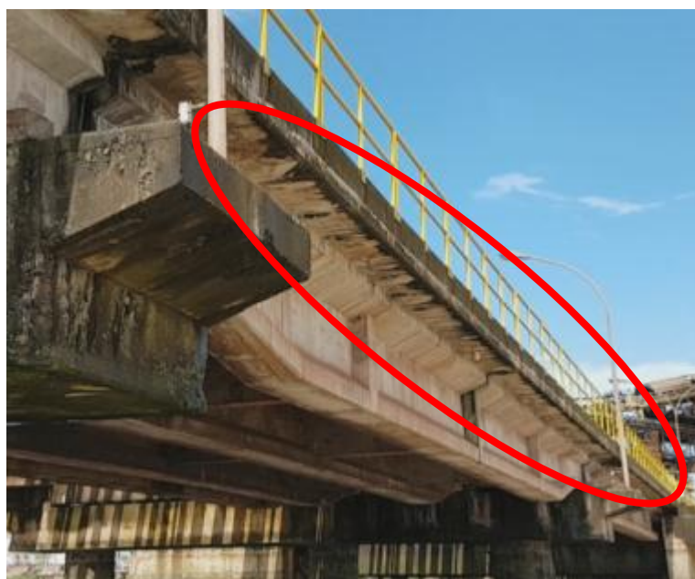
Figura 35 – Manchas de Eflorescência ao longo da Ponte de Acesso do Berço 106
