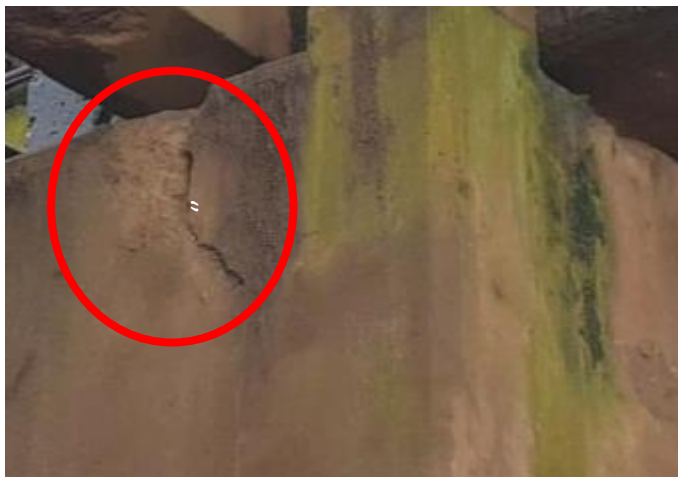
Figura 21 – Concreto Disgregado Profundo no Bloco BL3
