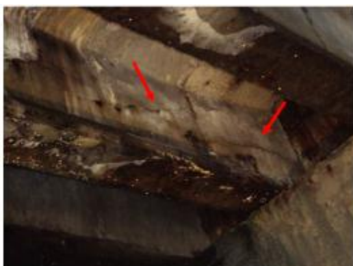
Foto 36- VSE7c -Apresentando fissuras transversais na região da alma próximo ao apoio da peça.
