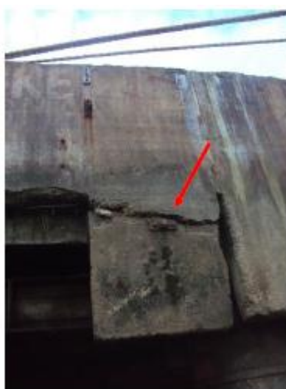
Foto 27- Placa de concreto com ruptura da seção transversal,
