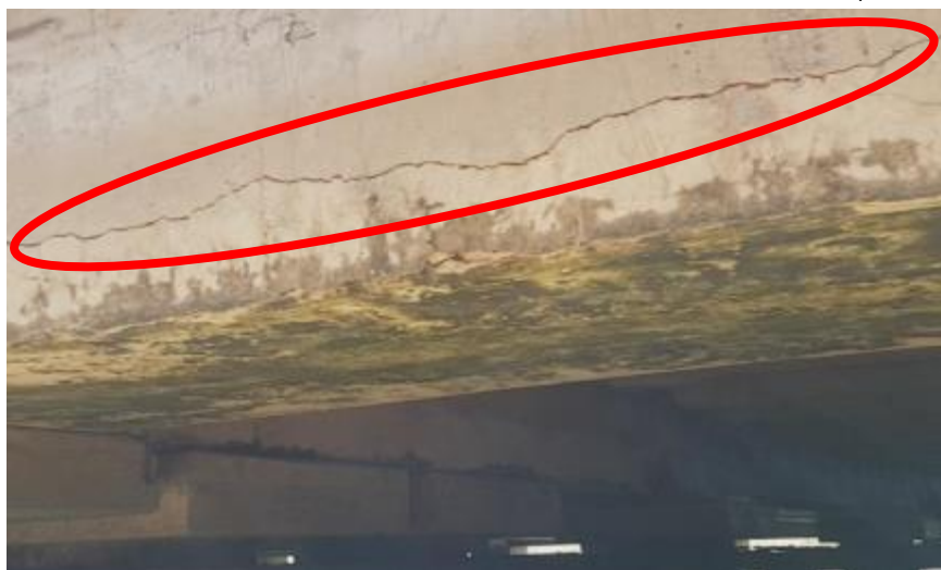
Figura 42 – Fissuras na Viga VPL2
