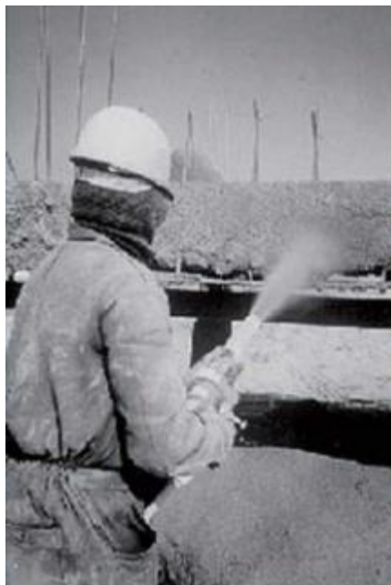
Figura 5.13 – Aplicação do concreto projetado.
