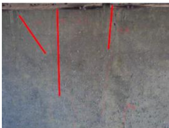
Foto 77- Detalhe de fissuras no Dolfim D10.
