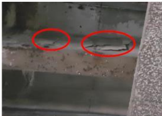
Foto 49- VSIc177-Concreto disgregado profundo
