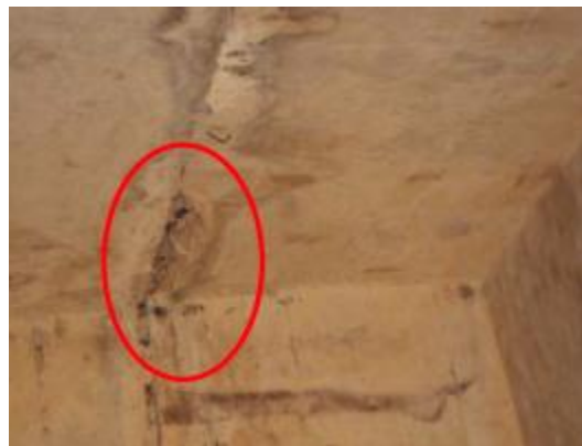
Foto 64- Concreto disgregado na VT22 entre E3 e E7 / E40 e E37.
