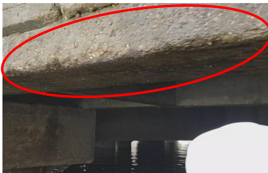
Figura 25 – Exposição do Agregado Graúdo na viga VPE1
