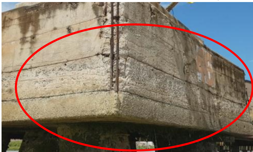
Figura 38 – Exposição do Agregado Graúdo no Dolfim D9
