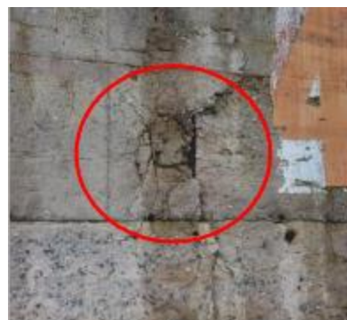
Foto 108- Concreto Segregado (profundidade < 4cm)
