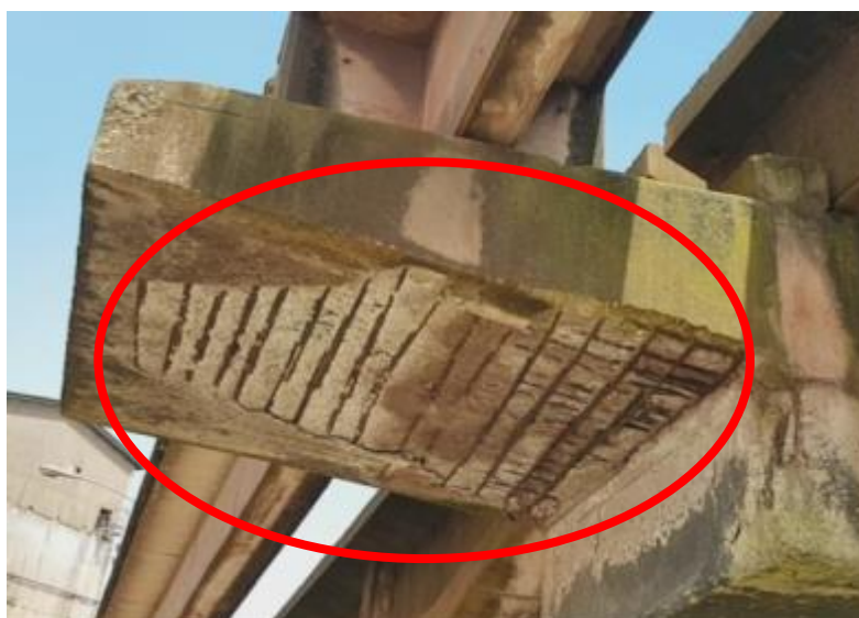
Figura 26 – Concreto Disgregado com AEO Profundo no Bloco BL4
