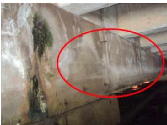
Foto 43- Manchas de eflorescência na face lateral da VPT entre E3-E40.
