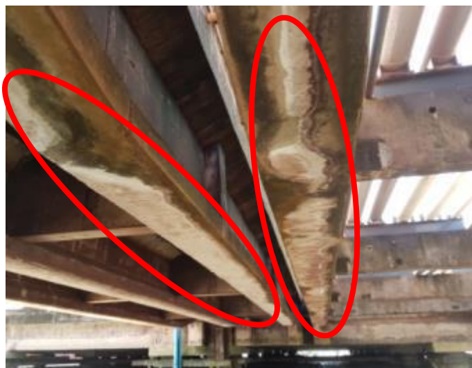
Figura 34 – Manchas de Eflorescência na Viga VL2 da Ponte de Acesso
