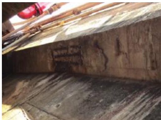
Foto 23– Concreto Disgregado com perda de seção nas armaduras da VL3.
