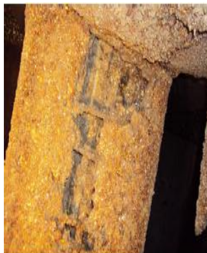
Foto 5- Concreto disgregado com armadura exposta e oxidada próximo ao apoio.(entre estacas T-32 a T-61)
