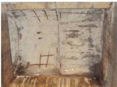
Foto 30- Face inferior da laje apresentando concreto disgregado com armadura exposta e oxidada.
