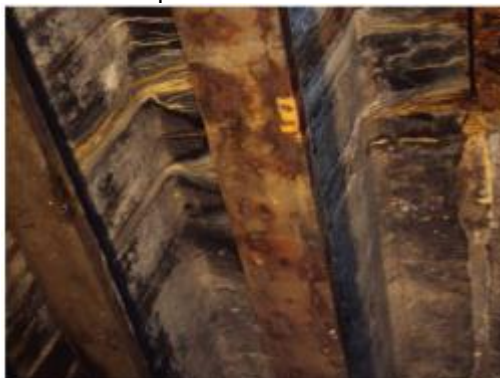
Foto 41- Mesa inferior da VSIb103 presença de armadura exposta e oxidada
