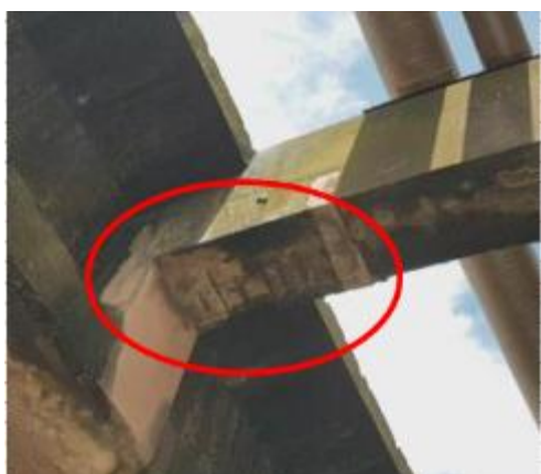
Foto 97- Concreto Disgregado com armadura exposta e oxidada (profundidade <4cm) na VT3
