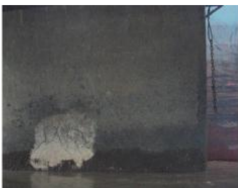
Foto 69- Detalhe de fissuras no paramento da E38.
