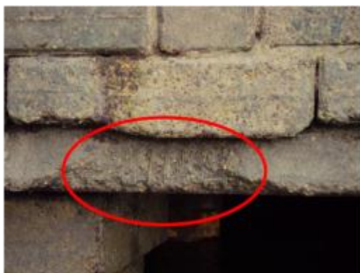
Foto 14- Mesa superior da viga com a presença de concreto disgregado com armadura exposta e oxidada (entre as estacas T-90 a T-91)
