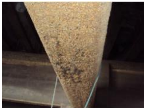
Foto 8- Concreto segregado superficial (entre estacas T-36 a T-65)
