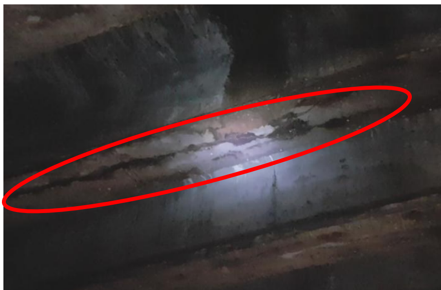
Figura 24 – Manchas de Oxidação Na viga VSIb85
