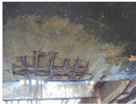
Foto 12- BL6 – Concreto disgregado com perda de seção nas armaduras principais e estribos rompidos na face inferior do bloco.
