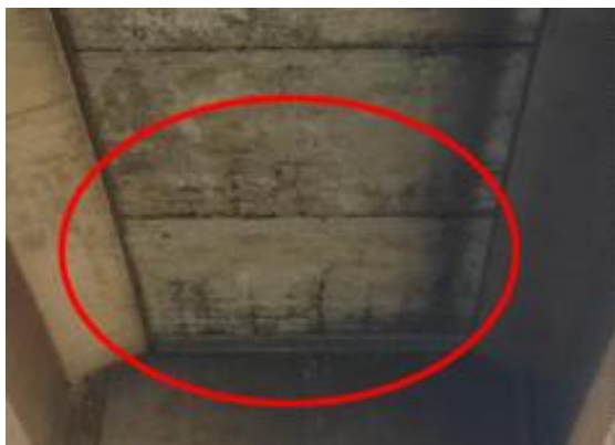
Foto 105- Concreto Segregado
