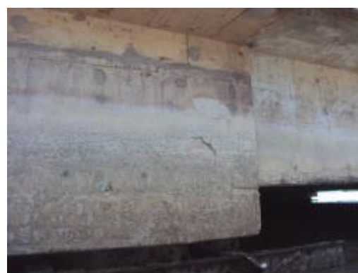
Foto 40- Concreto Disgregado no bloco sobre as estacas E25 a E28.
