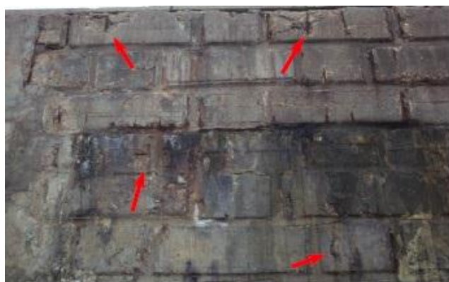
Foto 23- Desgaste superficial e concreto disgregado com armadura exposta e oxidada.
