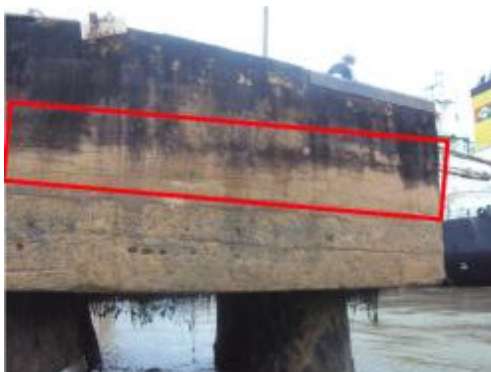
Foto 73- Detalhe de fissuras no Dolfim D6.
