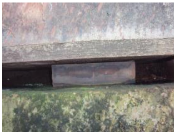
Foto 19- Aparelho de apoio da VL da passarela sobre D4.
