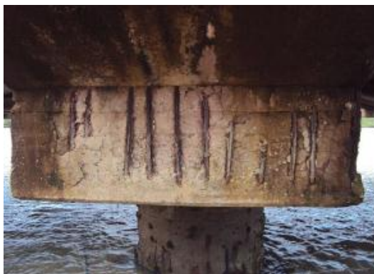
Foto 9- BL2-Concreto disgregado com armadura exposta e oxidada.
