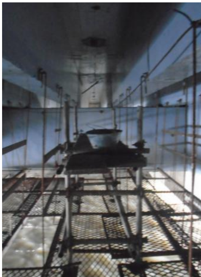
Figura 4.1 – Configuração Básica da Plataforma Metálica proposta.
