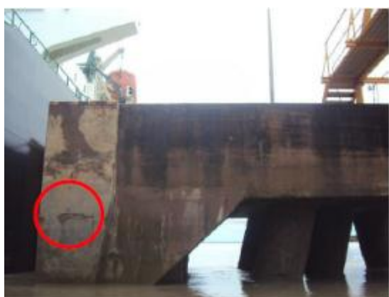
Foto 79- Concreto disgregado no paramento do Dolfim D10.
