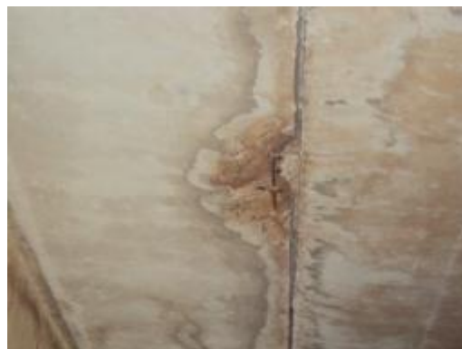
Foto 62- Concreto disgregado com armadura, exposta e oxidada na VT14 entre E6 e E5 / E42 e E43.
