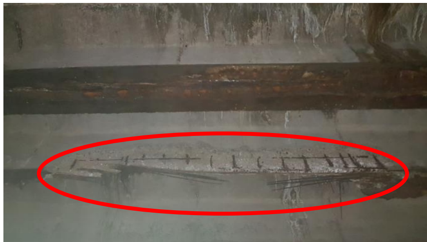
Figura 19 – Concreto Disgregado com AEO Profundo na lateral do Elemento 2
