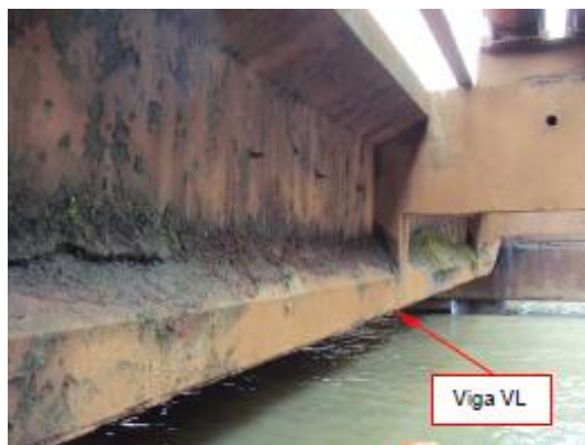
Figura 10 – Vista das Vigas Longarinas VL sobre travessas da Ponte de Acesso
