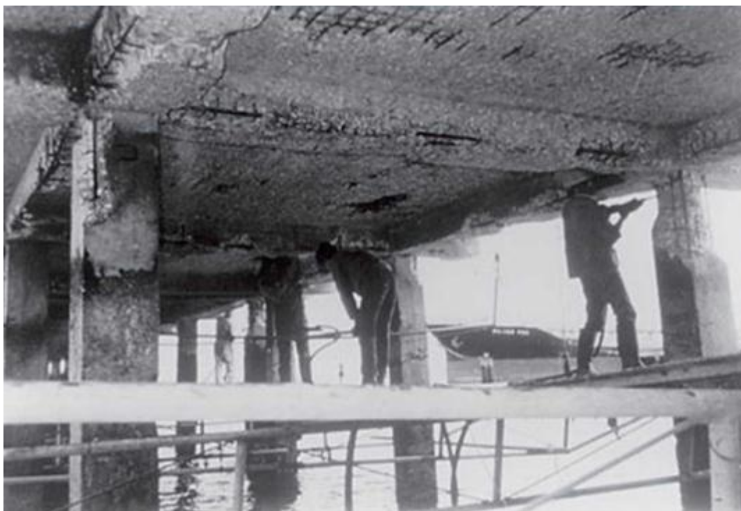
Figura 5.6 – Trabalho de campo de remoção do concreto deteriorado por corte.
