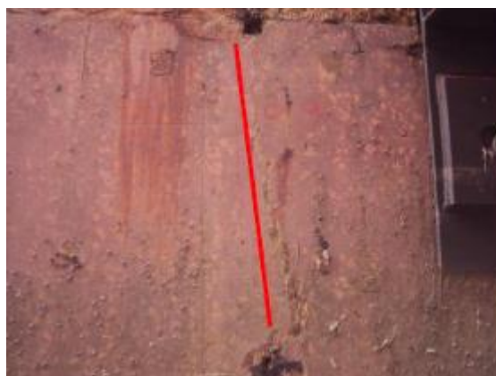
Foto 78- Detalhe de fissuras no Dolfim D14.
