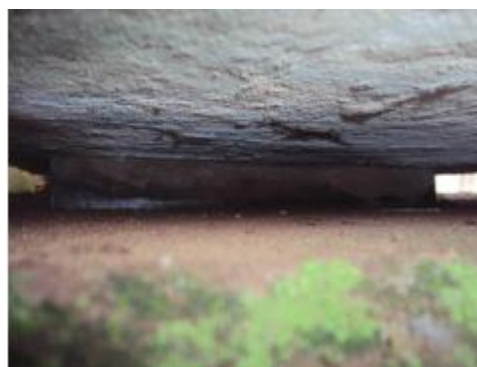
Foto 18- Aparelho de apoio da VL1 sobre bloco BL3.
