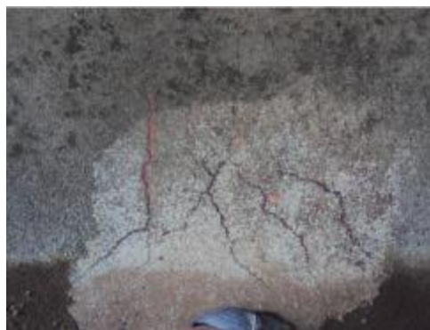
Foto 70- Detalhe de fissuras no paramento da E38.
