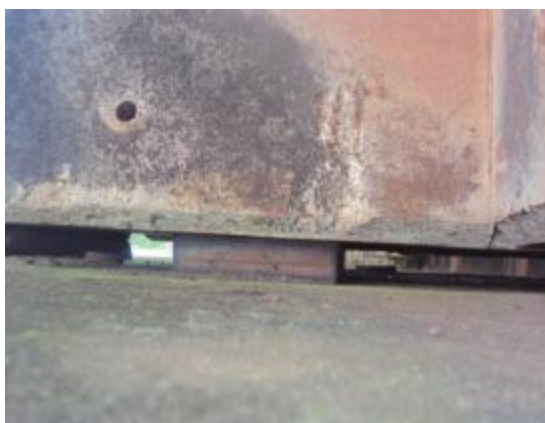
Foto 20- Aparelho de apoio da VL da passarela sobre BL3.
