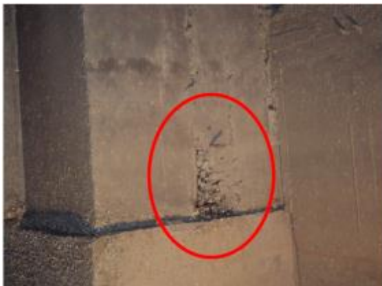
Foto 11- Concreto segregado
