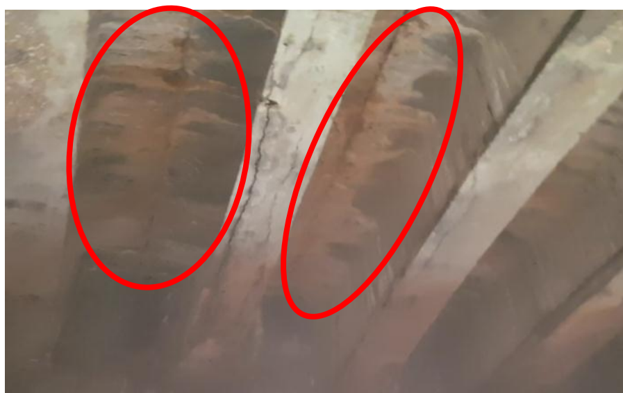
Figura 22 – Manchas de Eflorescência na viga VSEc148
