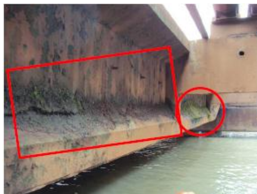
Foto 22– VL3-Incrustação dura na face lateral
