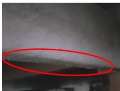
Foto 63-Concreto lixiviado na via de ligação das estacas
