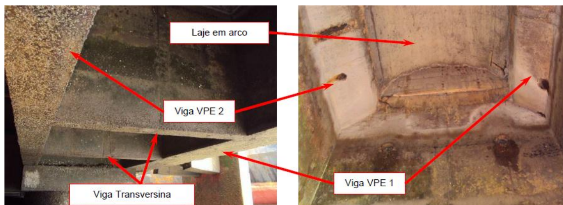
Figura 12 – Vista das vigas VT, VPE1, VPE2 e da Laje em Arco
