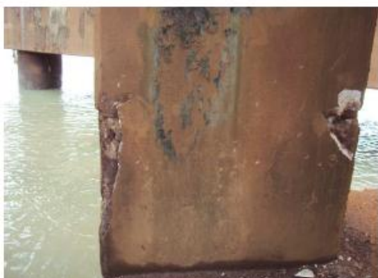
Foto 13- Bloco de apoio da longarina VL1 concreto disgregado com perda de seção nas armaduras.
