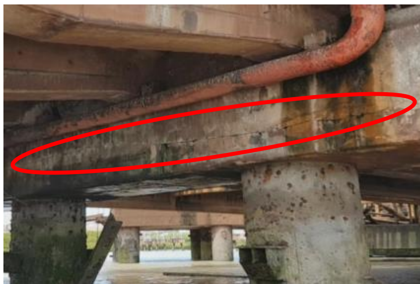
Figura 41 – Fissuras no Bloco BL2
