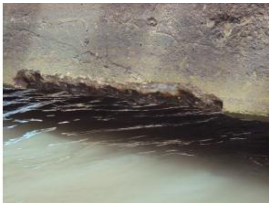
Foto 11- BL6-Concreto disgregado com perda de seção nas armaduras principais e estribos rompidos na face lateral e inferior.
