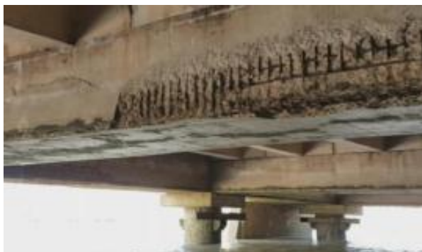
Foto 102- Concreto Disgregado com armadura exposta e oxidada (profundidade >4cm) na VPT3
