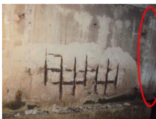
Foto 44- Manchas de eflorescência na face lateral VPT entre E4-E41.
