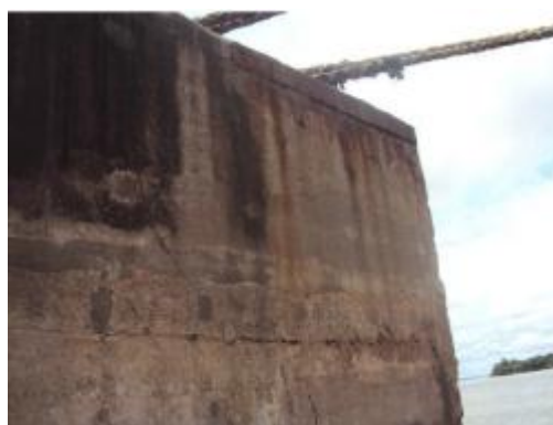
Foto 74- Detalhe de fissuras no Dolfim D9.
