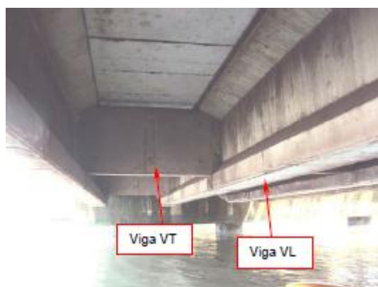
Figura 11 – Vista das Transversinas entre as Vigas VL4 e VL5 da Ponte de Acesso
