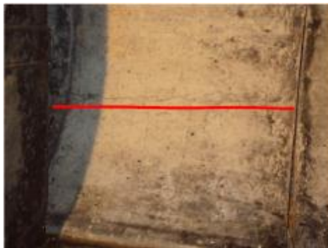
Foto 31- Fissuras na face inferior da laje
