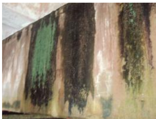
Foto 42- Manchas de umidade na face lateral VPT entre E1-E38.
