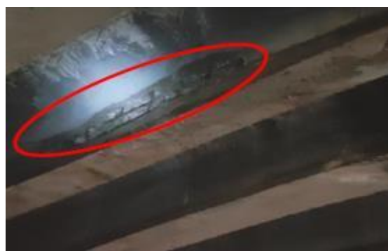
Foto 55- VSE-Concreto disgregado profundo com armadura exposta e oxidada
