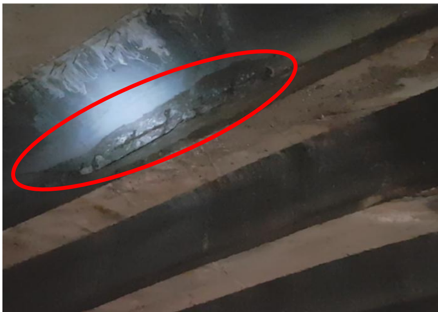
Figura 20 – Concreto Disgregado com AEO Profundo Na viga VSE
