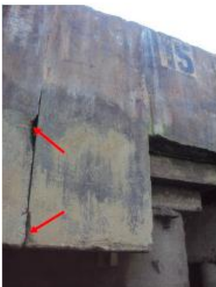
Foto 26- Concreto disgregado na borda da placa.
