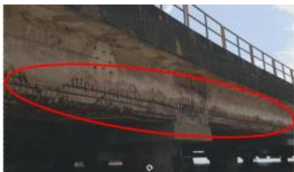
Foto 99- Concreto Disgregado com armadura exposta e oxidada (profundidade >4cm) na VPL1
