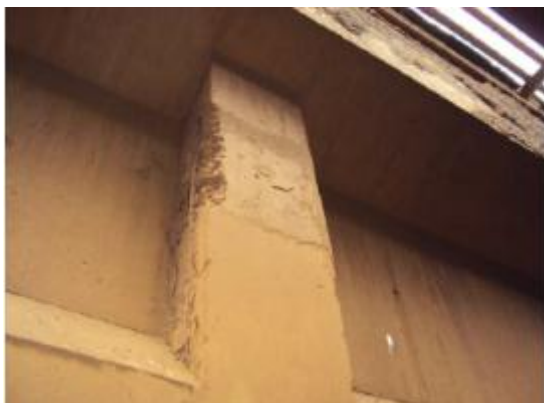
Foto 29- Concreto Disgregado com armadura exposta na VT3.
