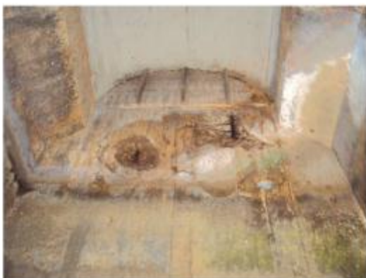
Foto 20- Lateral da viga com a presença de concreto disgregado com armadura oxidada.
