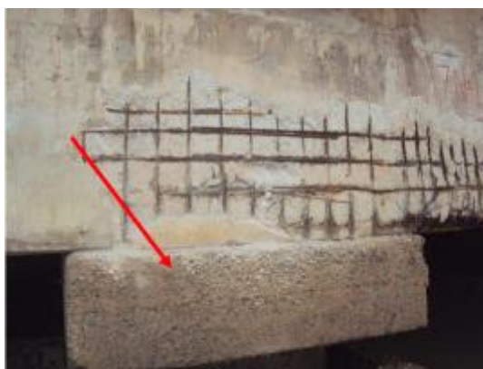
Foto 37- Exposição de agregado graúdo no capitel da estaca E15.
