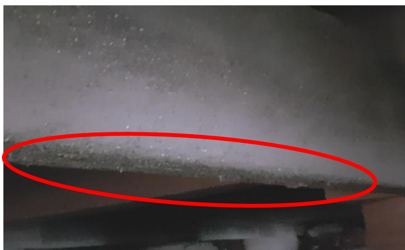
Figura 27 – Concreto Lixiviado na via de ligação das estacas
