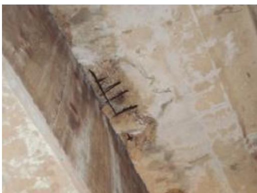
Foto 61- Concreto disgregado com armadura exposta e oxidada na VT1 entre E1 e E2 / E38 e E39.
