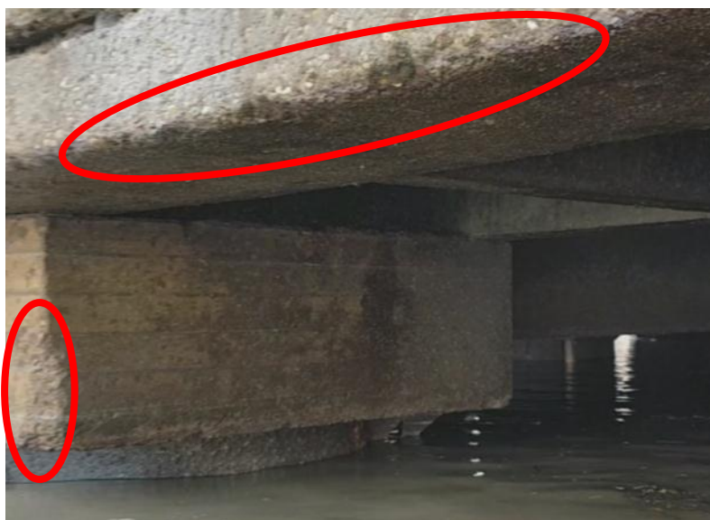
Figura 26 – Concreto Lixiviado no Capitel e na viga VPE1
