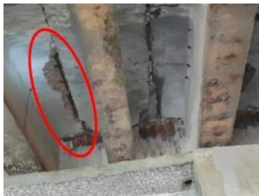
Foto 53- VSEc22-Concreto disgregado profundo com armadura exposta e oxidada
