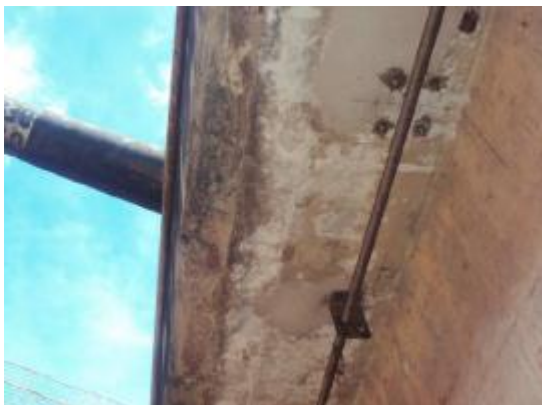
Foto 57- Concreto disgregado na borda da aba da VPL entre E38 e E43.
