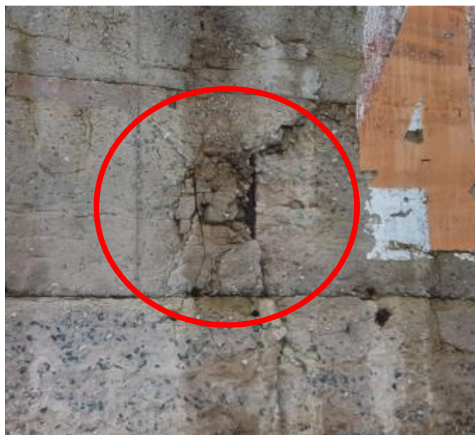
Figura 32 – Concreto Segregado Superficial no Dolfim D9
