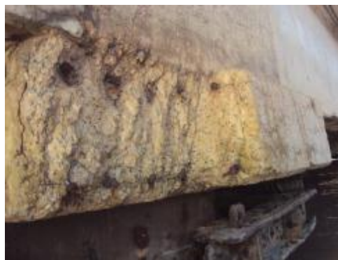
Foto 34- Capitel da estaca E41 apresentando ruptura de sua seção.
