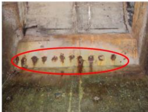
Foto 15- Mesa superior da viga com a presença de concreto disgregado com armadura exposta e oxidada (entre as estacas T-90 a T-91)
