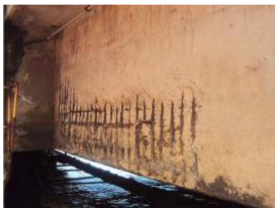
Foto 55- Concreto disgregado com armadura exposta e oxidada na lateral da VPL no alinhamento entre E1 e E6.
