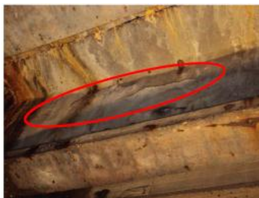
Foto 37- VSE66c- Apresentando fissuras transversais na alma.
