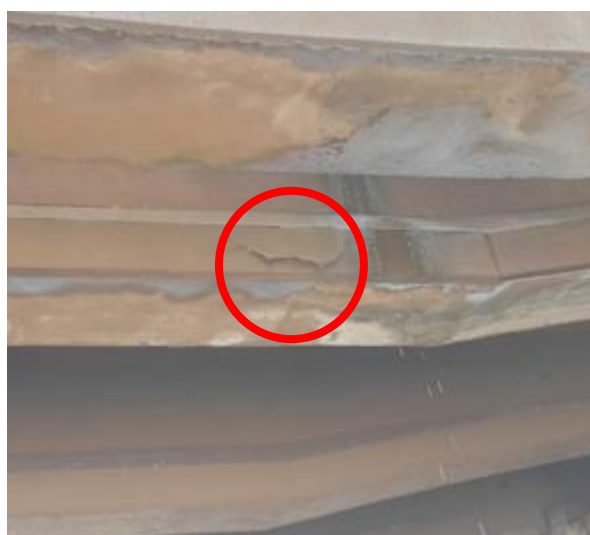
Figura 20 – Concreto Disgregado Superficial na Viga VL2
