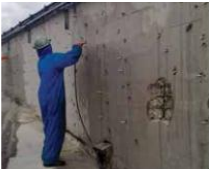
FIGURA 5.17 – Aplicação de injeção de microconcreto.
