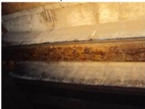
Foto 40- Mesa inferior da VSIb23 presença de armadura exposta e oxidada.
