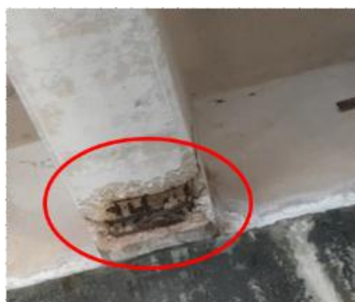
Foto 98- Concreto Disgregado com armadura exposta e oxidada (profundidade >4cm) na VT24
