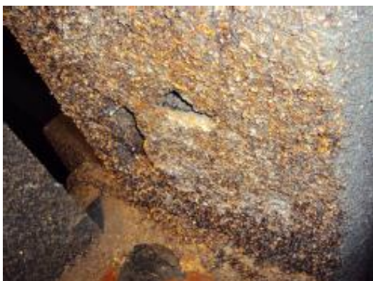
Foto 6- Concreto segregado profundo (entre estacas T-32 a T-62)
