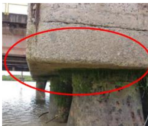
Foto 112 –Concreto lixiviado no Dólmil D4
