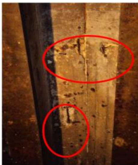
Foto 35- Face inferior da mesa superior da viga VSE com concreto disgregado e armadura exposta e oxidada.
