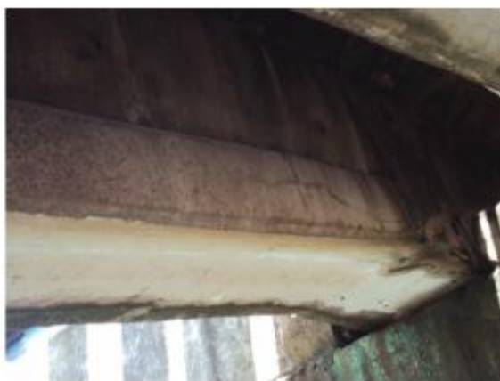
Foto 25– Concreto Disgregado na VL2.
