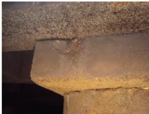
Foto 29- Capitel sobre a estaca T-70 com a presença de concreto disgregado.
