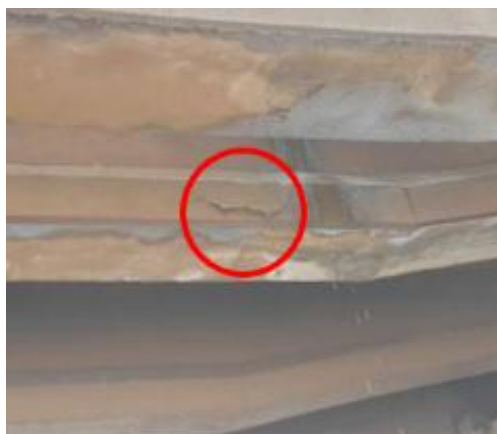
Foto 94- Concreto Disgregado superficial (espessura <4cm) na VL2
