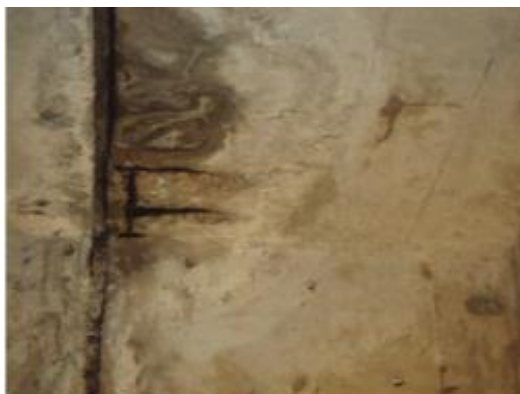
Foto 65- Concreto disgregado com armadura exposta e oxidada na VT1 entre E1 e E2 / E38 e E39.
