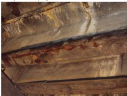
Foto 38- Mesa inferior da VSEc63 presença de concreto disgregado com armadura exposta e oxidada.
