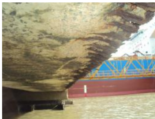
Foto 48- Concreto disgregado com armadura exposta e oxidada na VPT entre estacas E6 e E43.
