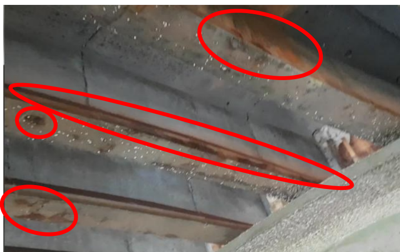
Figura 23 – Manchas de Oxidação Nas vigas VSEc13 e VSEc14
