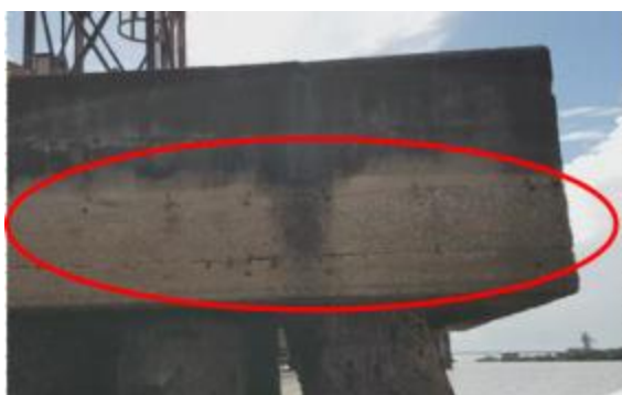
Foto 111- Exposição de agregado graúdo no Dólmil D5
