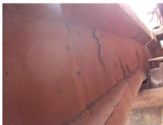
Foto 26– Concreto Disgregado na VL2.
