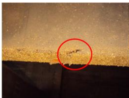
Foto 13- Mesa inferior da viga com a presença de concreto disgregado com armadura exposta e oxidada (entre as estacas T-4 a T-31)
