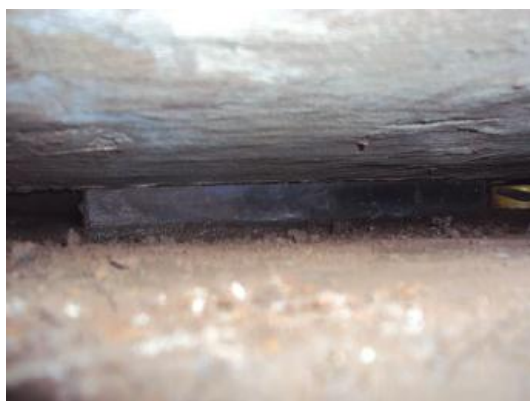
Foto 15- Aparelho de apoio da longarina VL1 sobre o bloco BL5.
