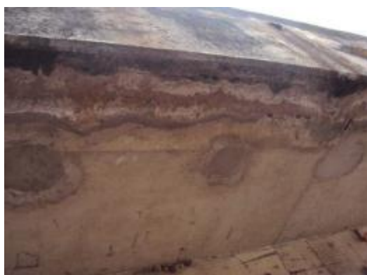
Foto 49- Manchas de eflorescência na aba da VPT entre estacas E1 e E38.
