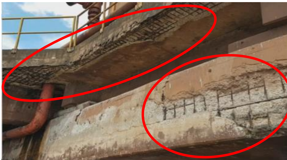
Figura 25 – Concreto Disgregado com AEO Profundo no Bloco BL2 e na Laje da Plataforma de Bombas
