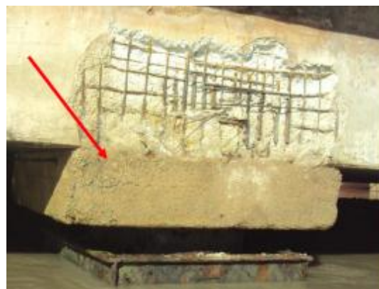
Foto 38- Exposição de agregado graúdo no capitel da estaca E74..
