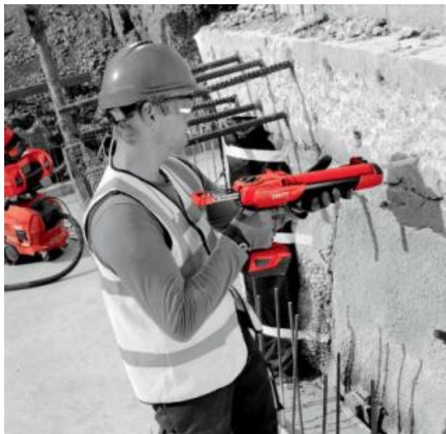
Figura 5.8 – Furação para ancoragem química de barras de aço CA50 ao concreto
