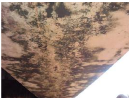
Foto 51- Manchas de umidade com impregnação de sujidades na face inferior da VPL entre E38 e E43.
