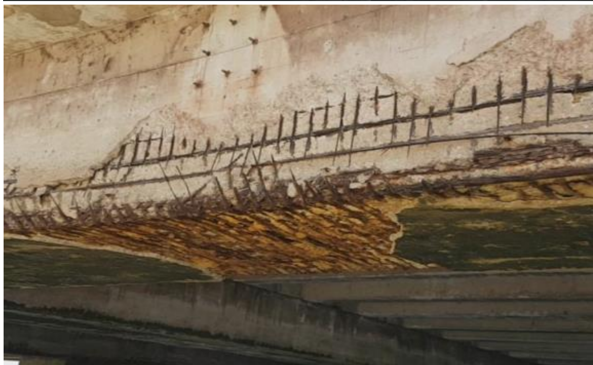
Figura 27 – Concreto Disgregado com AEO Profundo ao longo de Viga VPL1
