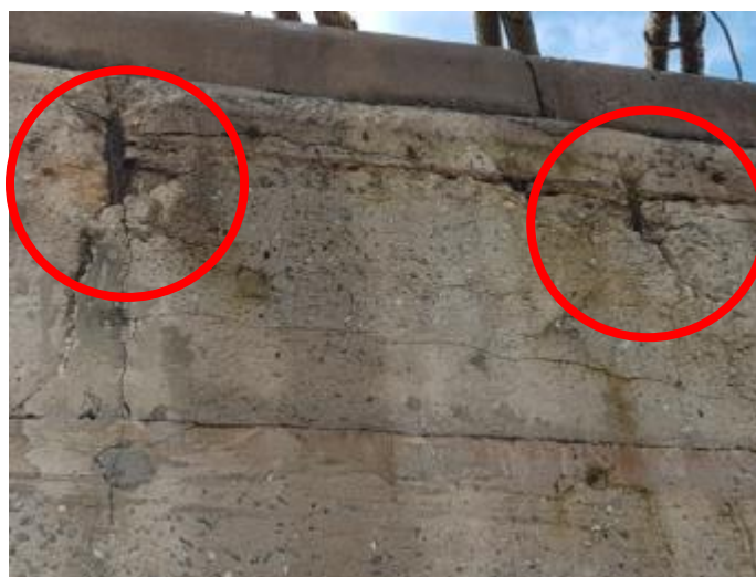
Figura 33 – Concreto Segregado com Armadura Exposta no Dolfim D9
