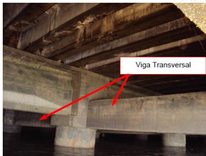
Figura 9 – Vista das Vigas Transversais
