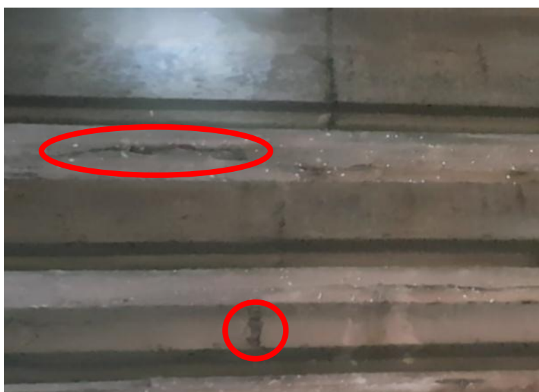
Figura 15 – Concreto Disgregado Superficial nas vigas VSIb
