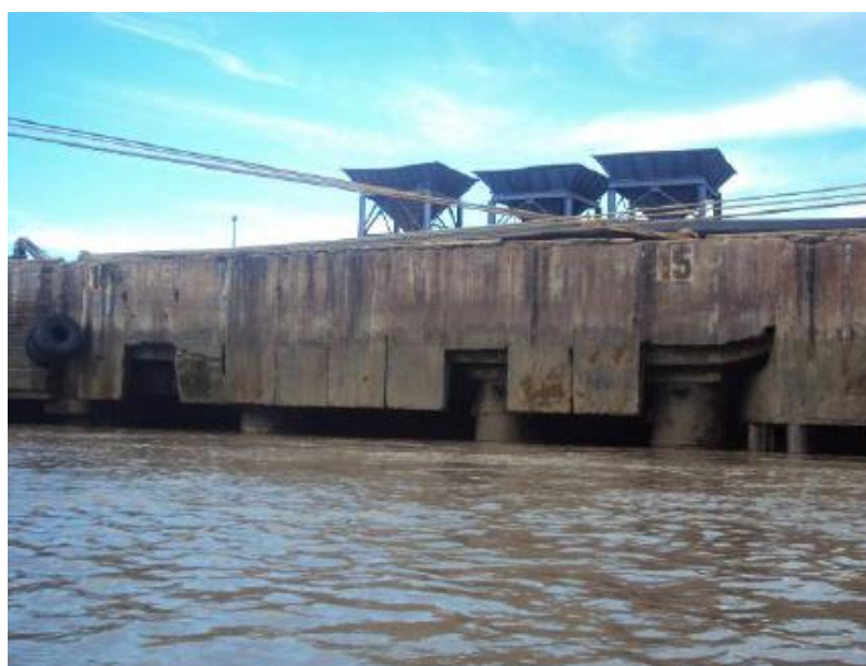
Figura 14 – Vista do paramento com fechamento com placas de concreto armado
