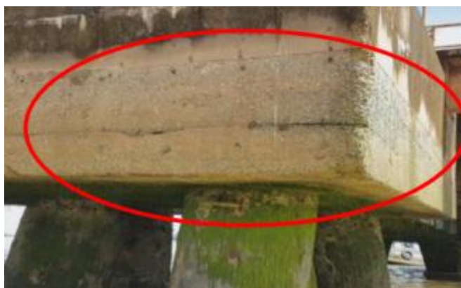
Foto 113 – Concreto lixiviado no Dolfim D5
