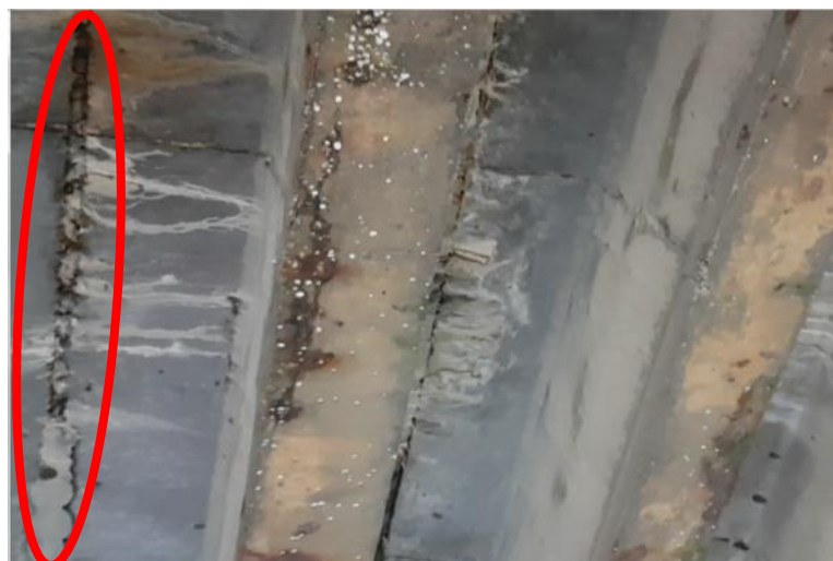
Figura 16 – Concreto Disgregado Profundo na viga VSEc
