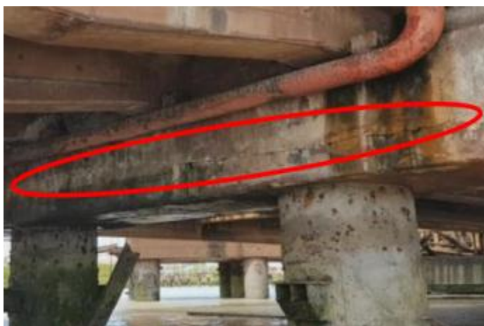
Foto 93- Fissuras no bloco BL2
