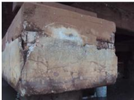
Foto 5 - BL2 - Concreto disgregado com armadura exposta e oxidada.
