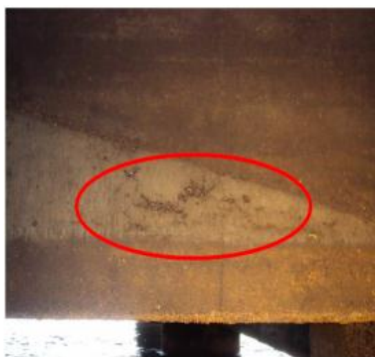
Foto 10- Concreto segregado (entre estacas T-33 a T-34)
