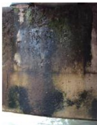
Foto 3 - BL5-Manchas de umidade e incrustações na face lateral.
