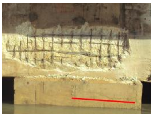
Foto 36- Concreto Disgregado e fissura no capitel da estaca E29.
