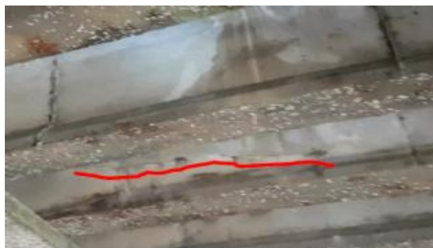
Foto 60- VSEc29- viga fissurada
