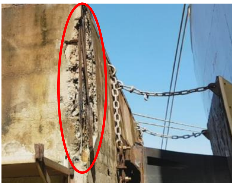
Figura 29 – Concreto Disgregado com AEO Profundo no Paramento da E38
