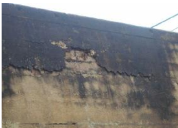
Foto 71- Concreto disgregado com armadura exposta e oxidada no Delfim D10.
