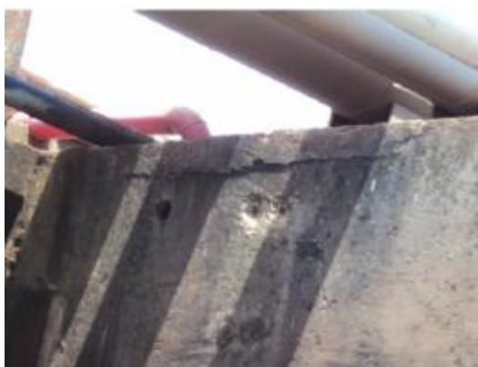
Foto 27- Concreto Disgregado com armadura exposta na VT2.
