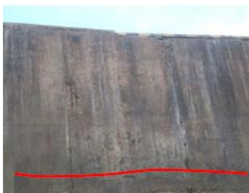
Foto 25- Fissura originada da ruptura da placa de concreto.
