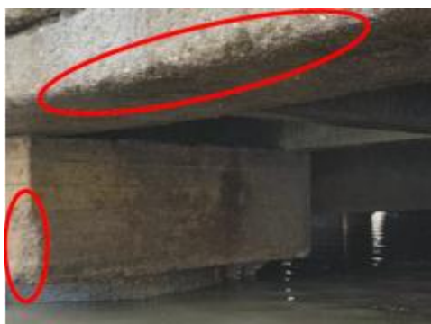
Foto 62- Concreto lixiviado
