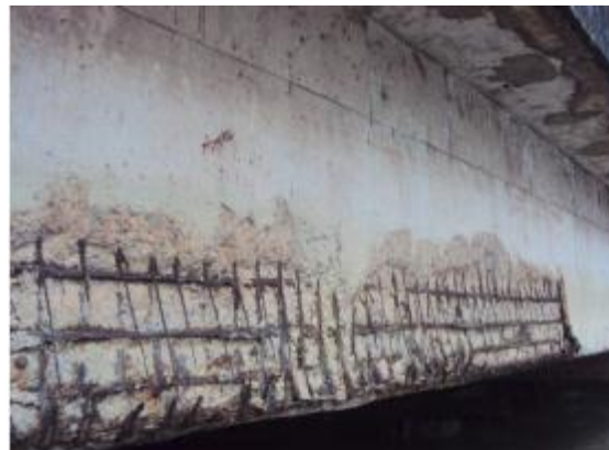
Foto 56- Concreto disgregado com armadura exposta e oxidada na lateral da VPL entre E1 e E6.
