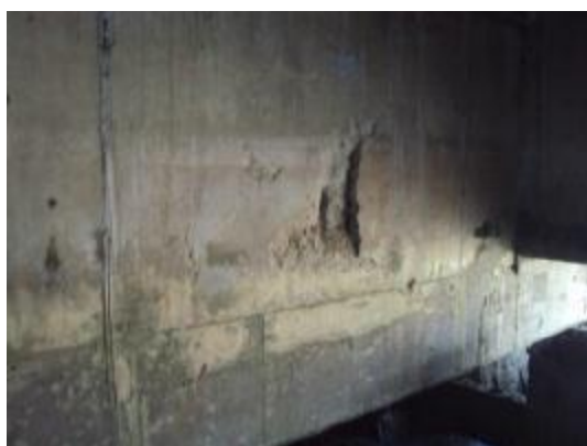
Foto 39- Concreto Disgregado no bloco sobre as estacas E16 a E19.
