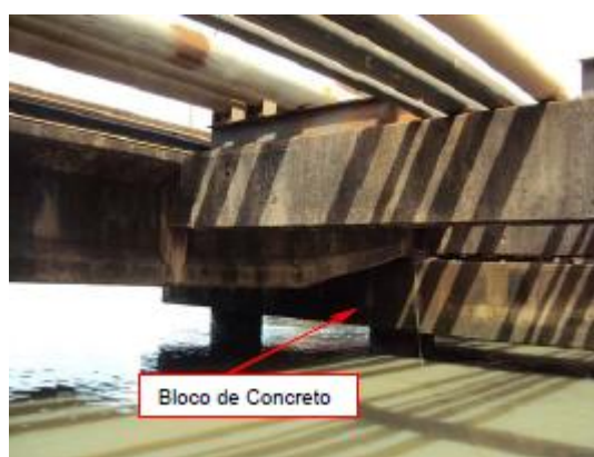
Figura 8 – Vista do Bloco BL sobre as estacas da Ponte de Acesso
