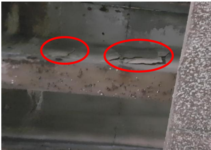
Figura 17 – Concreto Disgregado Profundo na viga VSIc177
