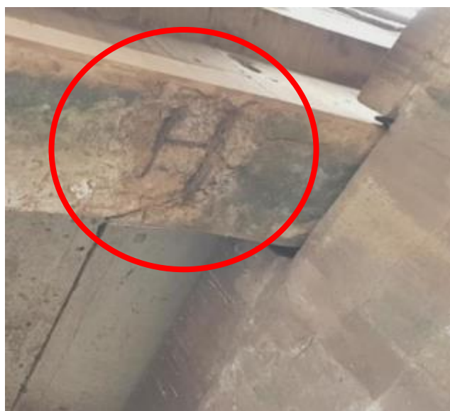
Figura 22 – Concreto Disgregado com AEO Superficial na Viga VL3
