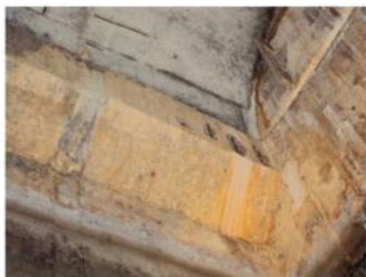
Foto 16- Mesa superior da viga com a presença de concreto disgregado com armadura exposta e oxidada.
