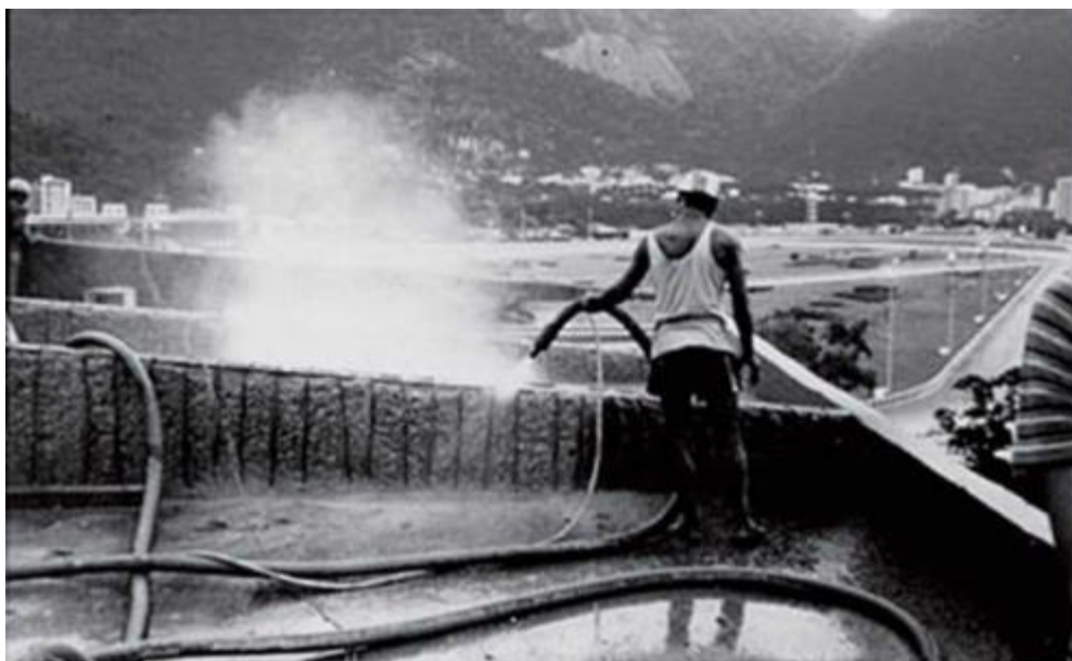
FIGURA 5.1 – Aplicação de hidrojateamento para limpeza da superfície do concreto
