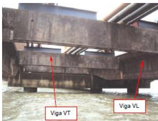
Figura 12 – Vista das Transversinas entre as Vigas VL1 e VL2 da Ponte de Acesso
