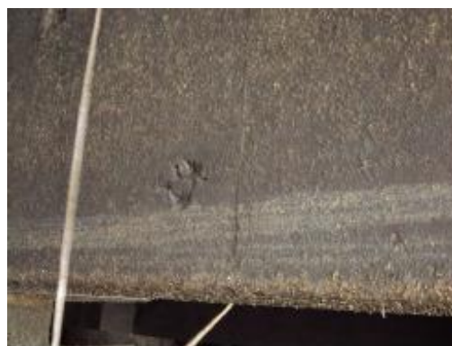
Foto 7- Concreto segregado superficial (entre estacas T-60 a T-80)
