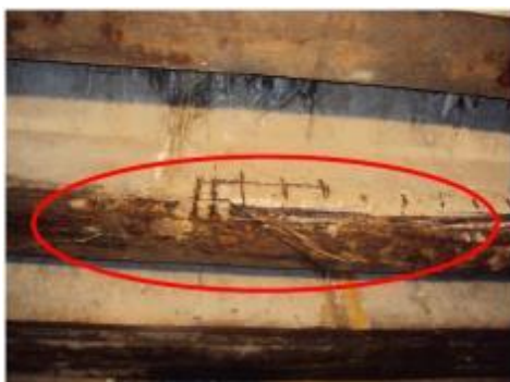
Foto 44- Lateral da VSEb93 (faceNW) com cordoalhas rompidas
