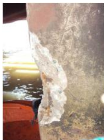
Foto 14- Bloco de apoio da longarina VL2 concreto disgregado com perda de seção nas armaduras.
