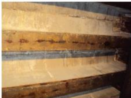
Foto 42- Mesa inferior da VS1b35 com concreto disgregado e fissuras.
