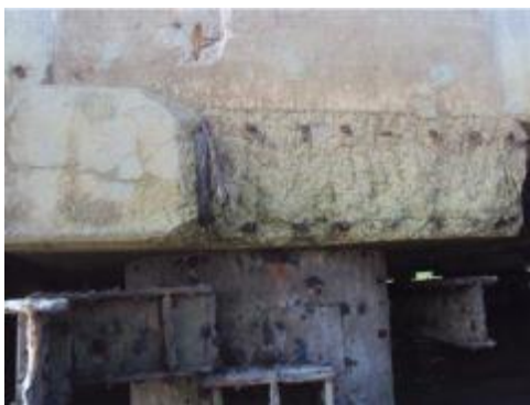
Foto 33- Capitel da estaca E40 apresentando ruptura de sua seção.
