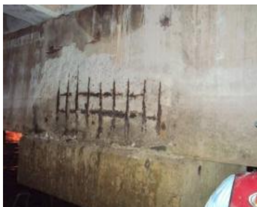
Foto 45- Concreto disgregado com armadura exposta e oxidada na VPT entre estacas E3 e E40.
