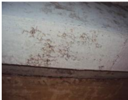
Foto 68- Concreto segregado na alma da VT7 entre E4 e E7 / E41 e E37.
