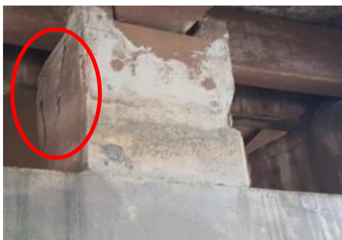
Figura 19 – Concreto Disgregado Superficial no Bloco BL2
