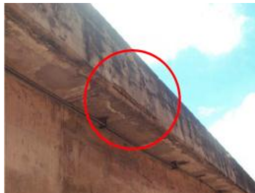
Foto 58- Manchas de eflorescência na aba da VPL entre E38 e E43.
