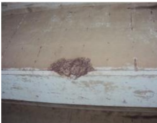
Foto 60- Concreto disgregado na VT2 entre E5e E6 / E42 e E43.
