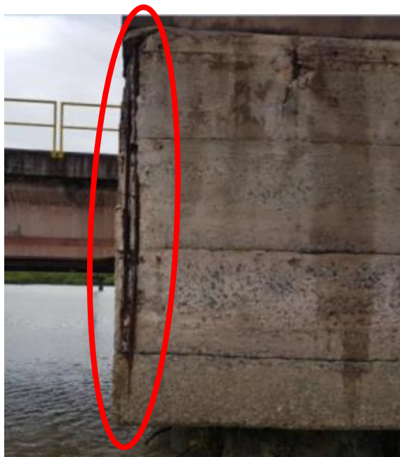
Figura 24 – Concreto Disgregado com AEO Profundo no Dolfin D9
