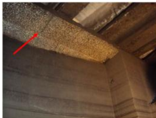
Foto 12- Mesa superior da viga com a presença de concreto disgregado com armadura exposta e oxidada (entre as estacas T-4 a T-31)
