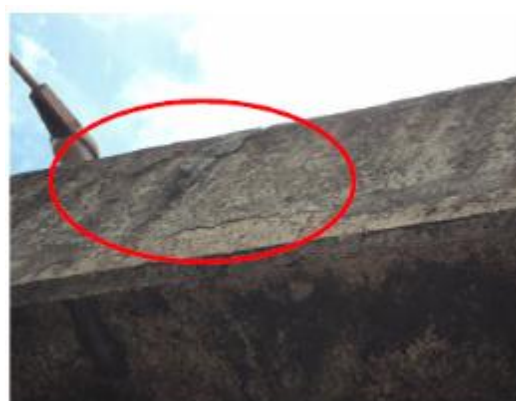
Foto 32- Concreto Disgregado com armadura exposta na laje entre D4-D8 e BL5.
