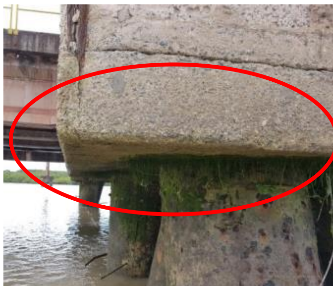
Figura 39 – Concreto Lixiviado no Dolfim D4
