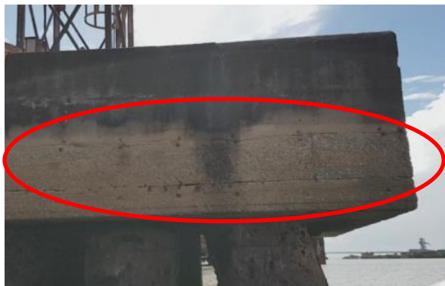
Figura 37 – Exposição do Agregado Graúdo no Dolfim D5
