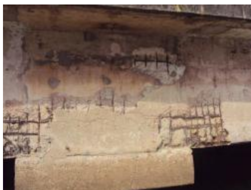
Foto 54- Concreto disgregado com armadura exposta e oxidada na região de ligação entre vigas no alinhamento do capitel da estaca E4.
