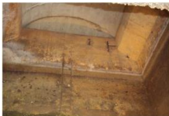
Foto 21- Lateral da viga com a presença de concreto disgregado com armadura exposta e oxidada.
