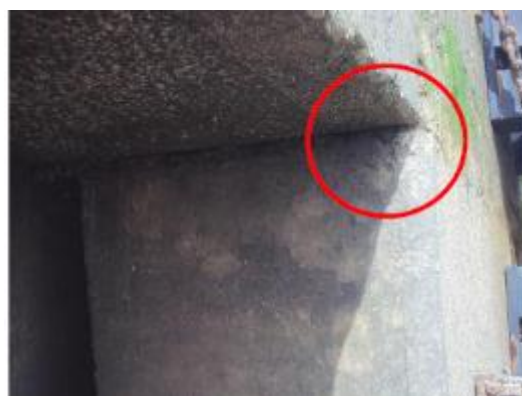
Foto 80- Concreto disgregado no paramento do Dolfim D14.
