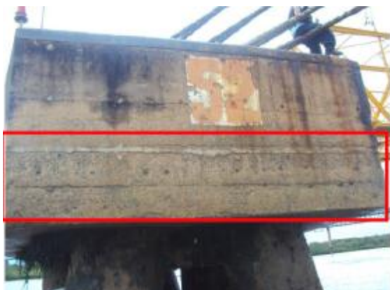
Foto 75- Exposição de agregado graúdo no Dolfim D6.
