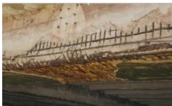
Foto 100- Concreto Disgregado com armadura exposta e oxidada (profundidade >4cm) na VPL1
