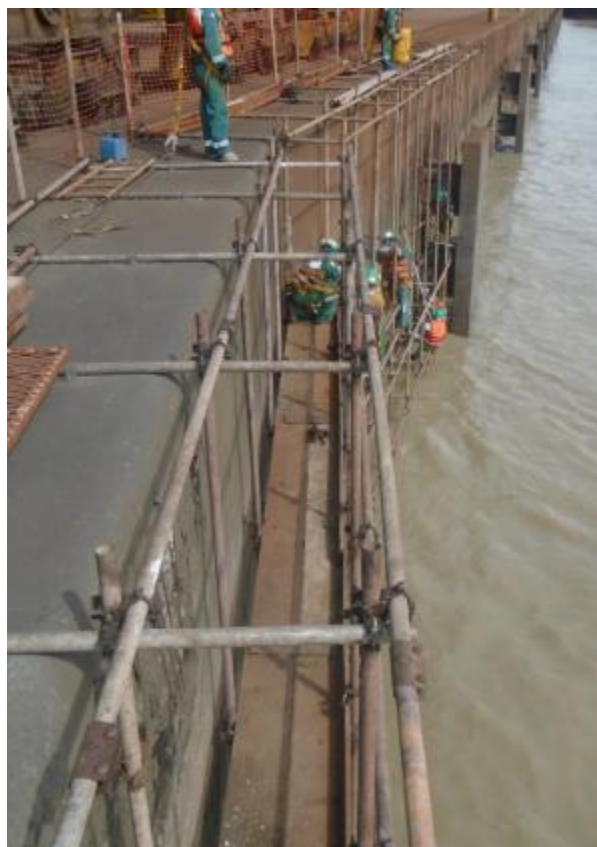
Figura 4.2 – Plataforma para acesso dos operários.
