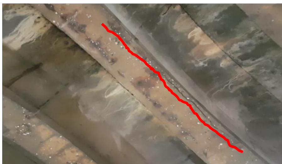
Figura 28 – Fissura na viga VSEc20
