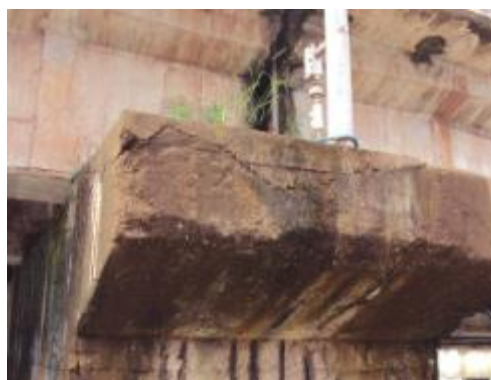
Foto 10- BL2 –Concreto disgregado com armadura exposta e oxidada.
