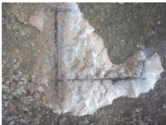
Foto 82-Início da oxidação da armadura.
