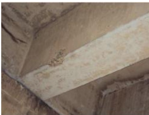
Foto 59- Concreto disgregado na VT3 da entre E1 e E2/ E38 e E39.
