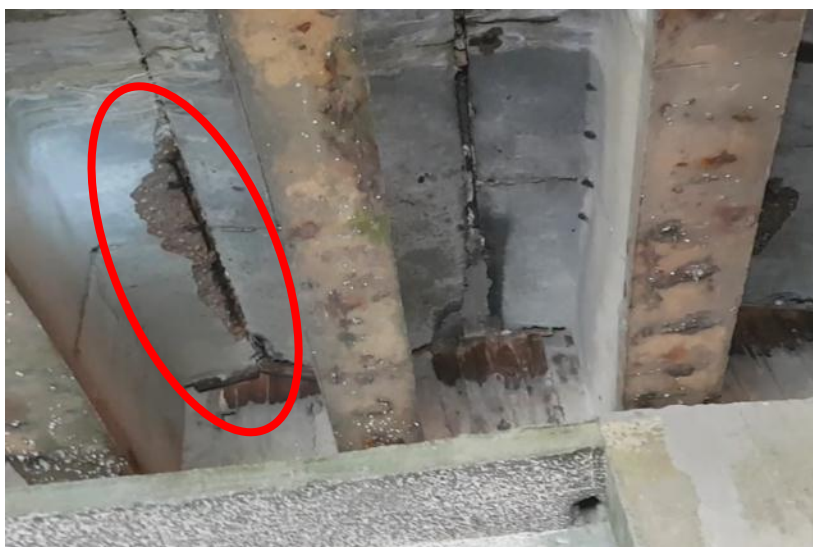
Figura 18 – Concreto Disgregado com AEO Profundo na viga VSEc22
