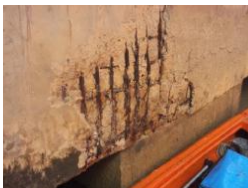
Foto 53- Concreto disgregado com armadura exposta e oxidada na região de ligação entre VPL no alinhamento do capitel da estaca E39.
