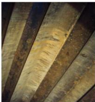
Foto 32- Face inferior da mesa superior com manchas de eflorescência na VSE.
