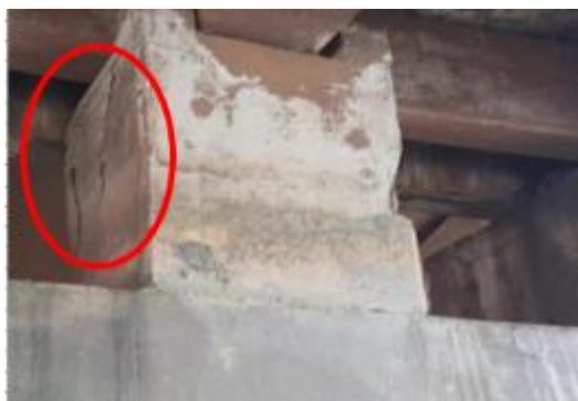
Foto 89- Concreto disgregado superficial (prof. < 4cm) no bloco BL2.
