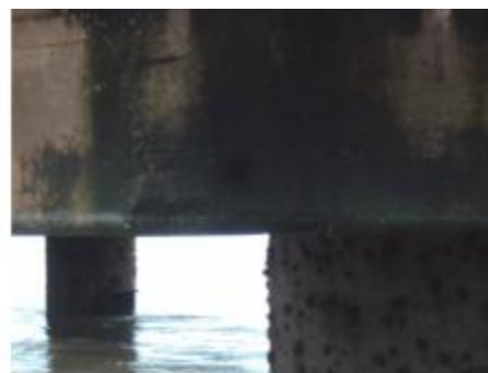
Foto 4 - BL6 -Manchas de umidade e incrustações dura na face lateral.
