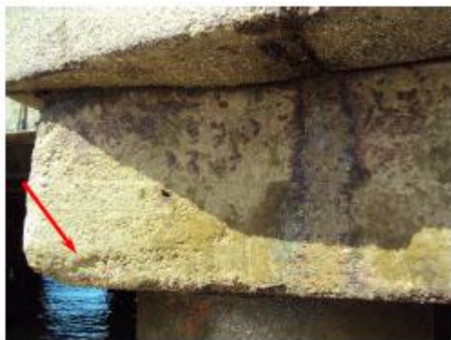
Foto 28- Capitel sobre a estaca T-88 com desgaste superficial e exposição de agregado graúdo.
