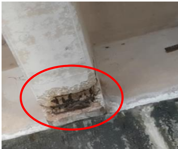
Figura 30 – Concreto Disgregado com AEO Profundo na Viga VT24
