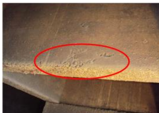
Foto 17- Alma da viga com a presença de concreto segregado superficial.
