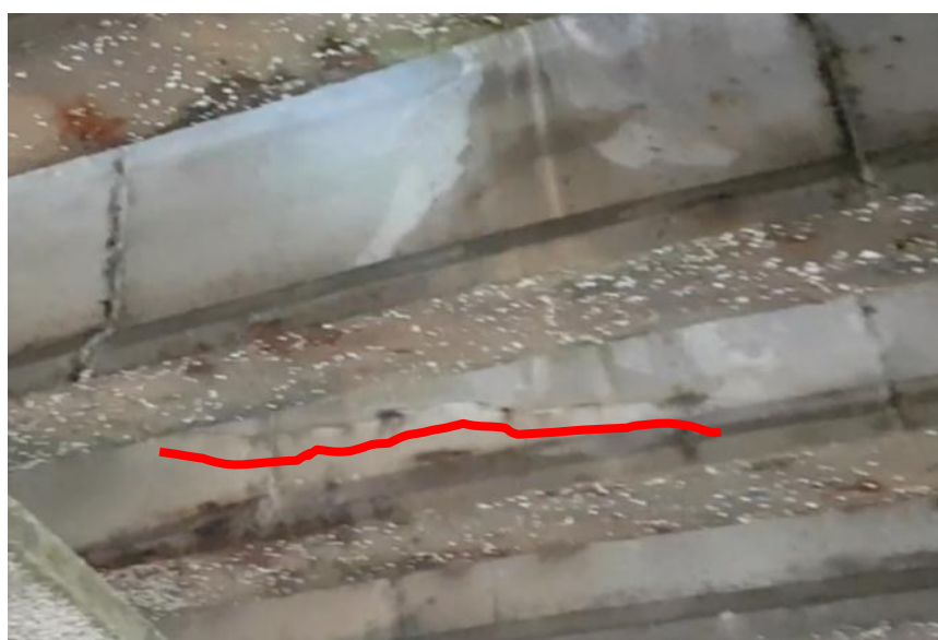
Figura 30 – Fissuras na viga VSEc29
