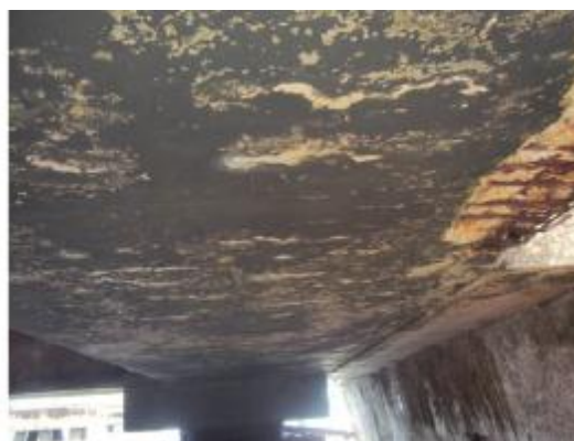
Foto 52- Manchas de umidade com impregnação de sujidades na face inferior da VPL entre E1 e E.3.
