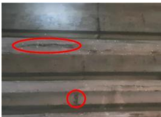
Foto 48- VSIb-Concreto disgregado superficial
