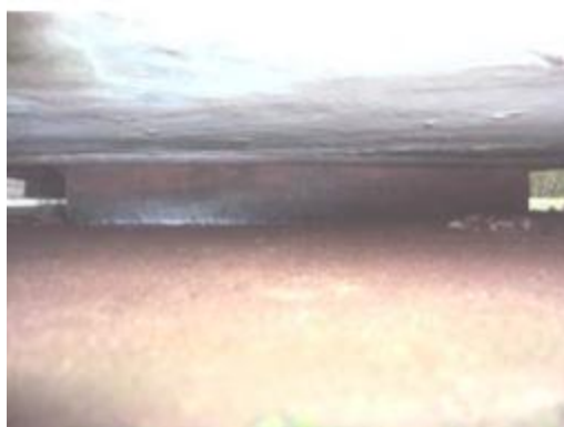
Foto 17- Aparelho de apoio da VL13 sobre o bloco BL6.
