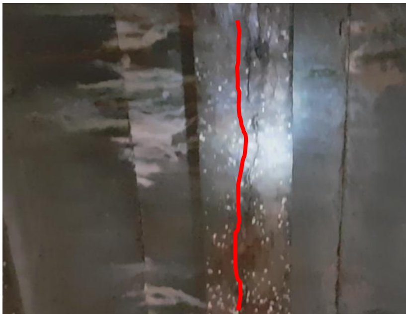
Figura 29 – Fissuras na viga VSEc36
