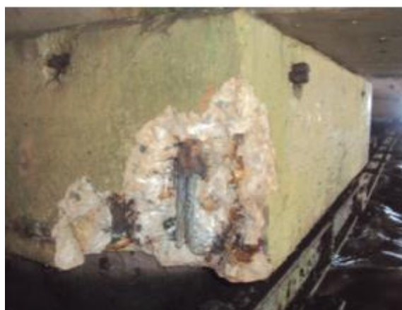
Foto 84-Corrosão nas armaduras.
