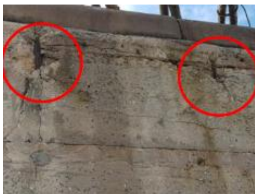
Foto 109 – Concreto segregado profundo com armadura exposta e oxidada
