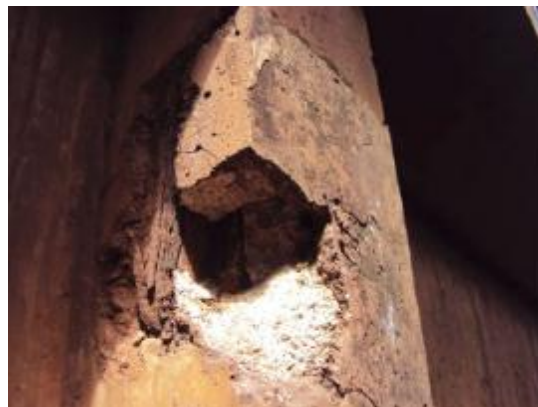
Foto 30- Concreto Disgregado com armadura exposta na VT2.
