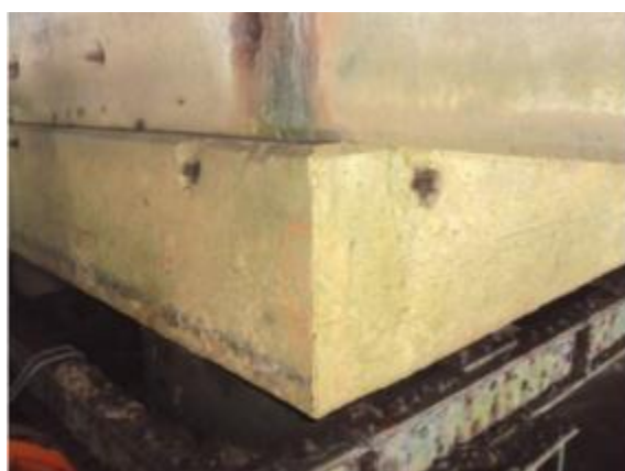
Foto 83- Fissuras por disgregação
