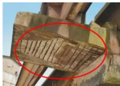
Foto 92 – Concreto disgregado profundo (prof. > 4cm) no bloco BL4.
