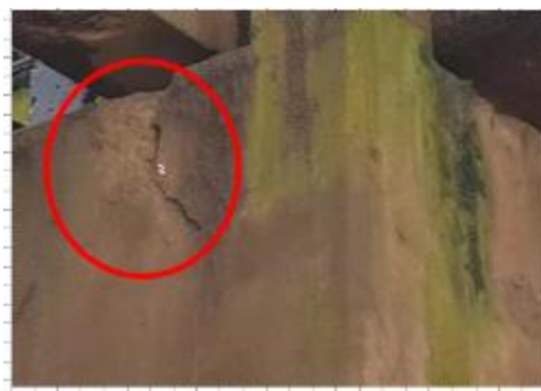
Foto 90 – Concreto disgregado profundo (prof. > 4cm) no bloco BL3.
